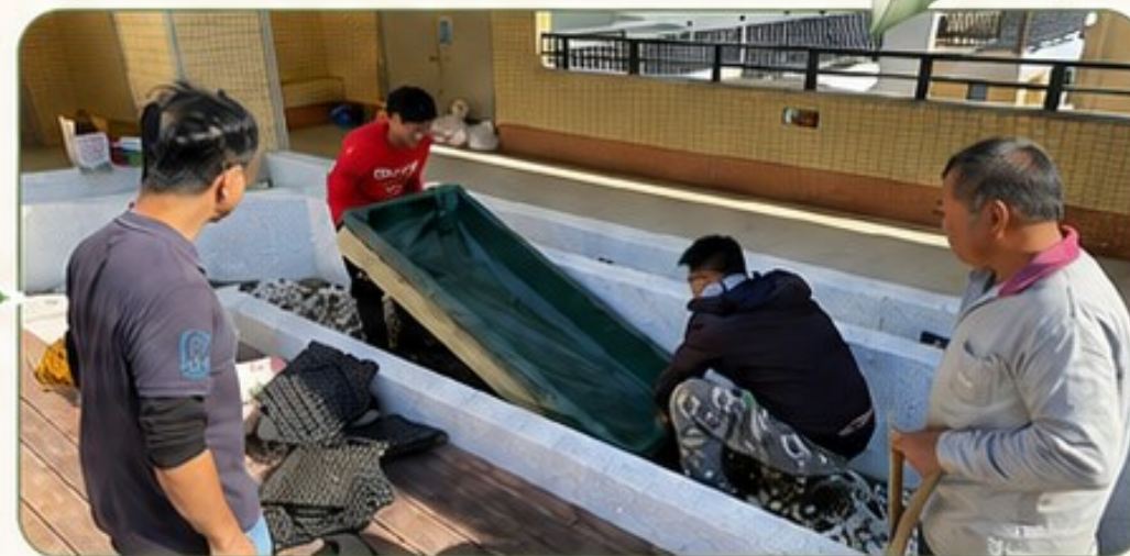
施作防水與排水層、鋪設介質、架設木造可食地景盆，為香草植物打造適合生長的环境。
