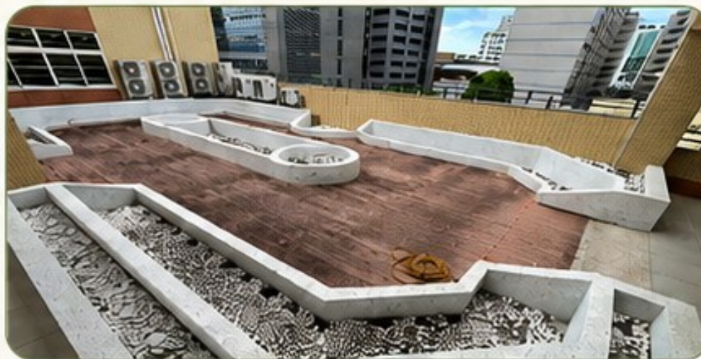
原4樓屋頂僅鋪白石，缺乏植栽與隔熱效果，夏季高溫不適，閒置未有效利用。
