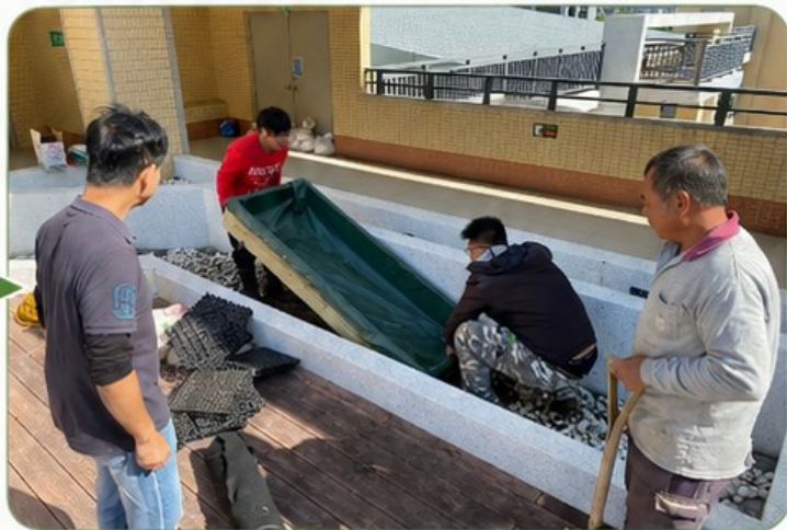
施作防水與排水層、鋪設介質、架設木造可食地景盆，為香草植物打造適合生長的環境。
