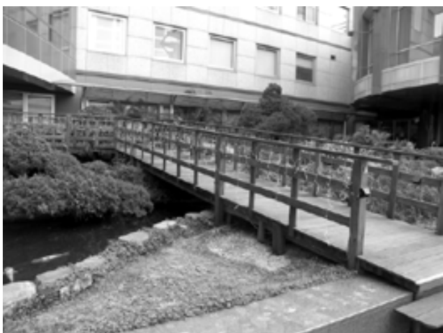
台北大樓門口的便橋。大樓進行內部整修之初，搭了一座暫時性木製便橋以供行走，不知不覺地，橋邊的綠意搭配池魚的生命力，漸漸形成一幅美好的畫面，無心插柳竟成蔭。施工完畢後要拆除時，員工爭取之下，保留了這座便橋。
