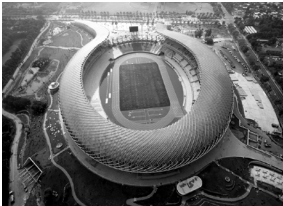
高雄世運館全景。自行研發的太陽能發電系統與面板，是台達傲人的成果之一。高雄世運館屋頂上所裝置的 8844 片太陽能電力模組，就是來自台達，為目前世界上最大的建築整合型戶外太陽能電力系統。
